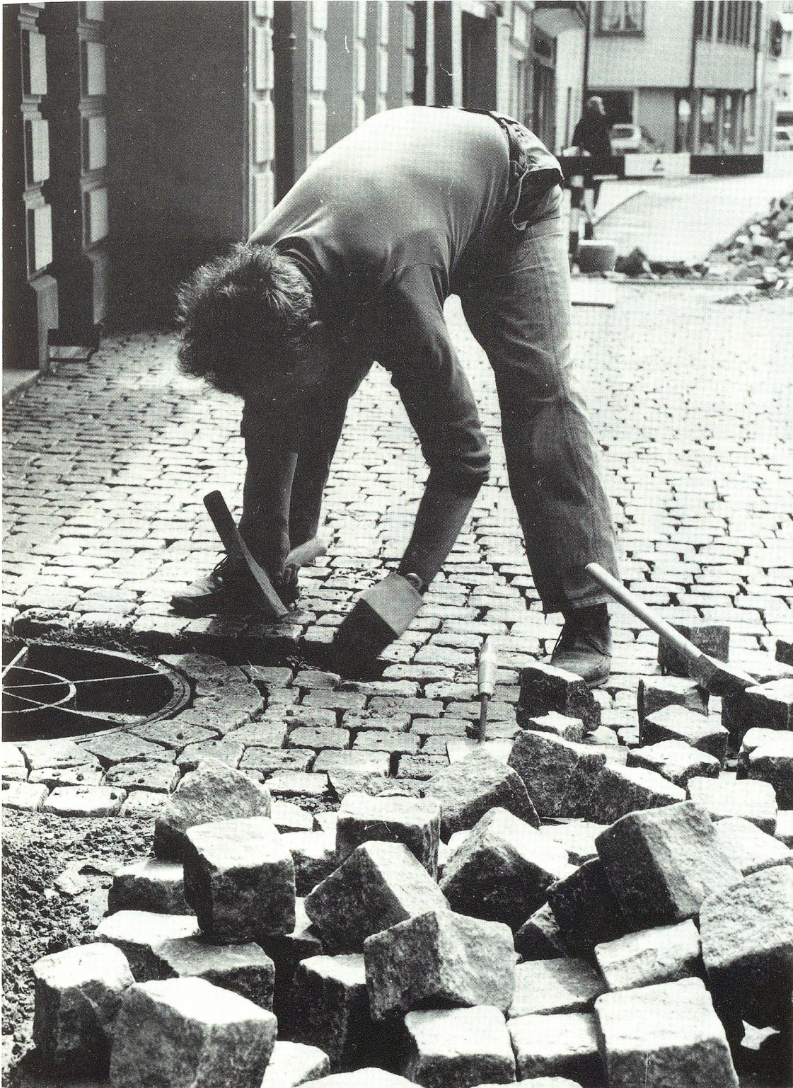
Fast wie in alten Zeiten – Pflästerer bei der Arbeit.
