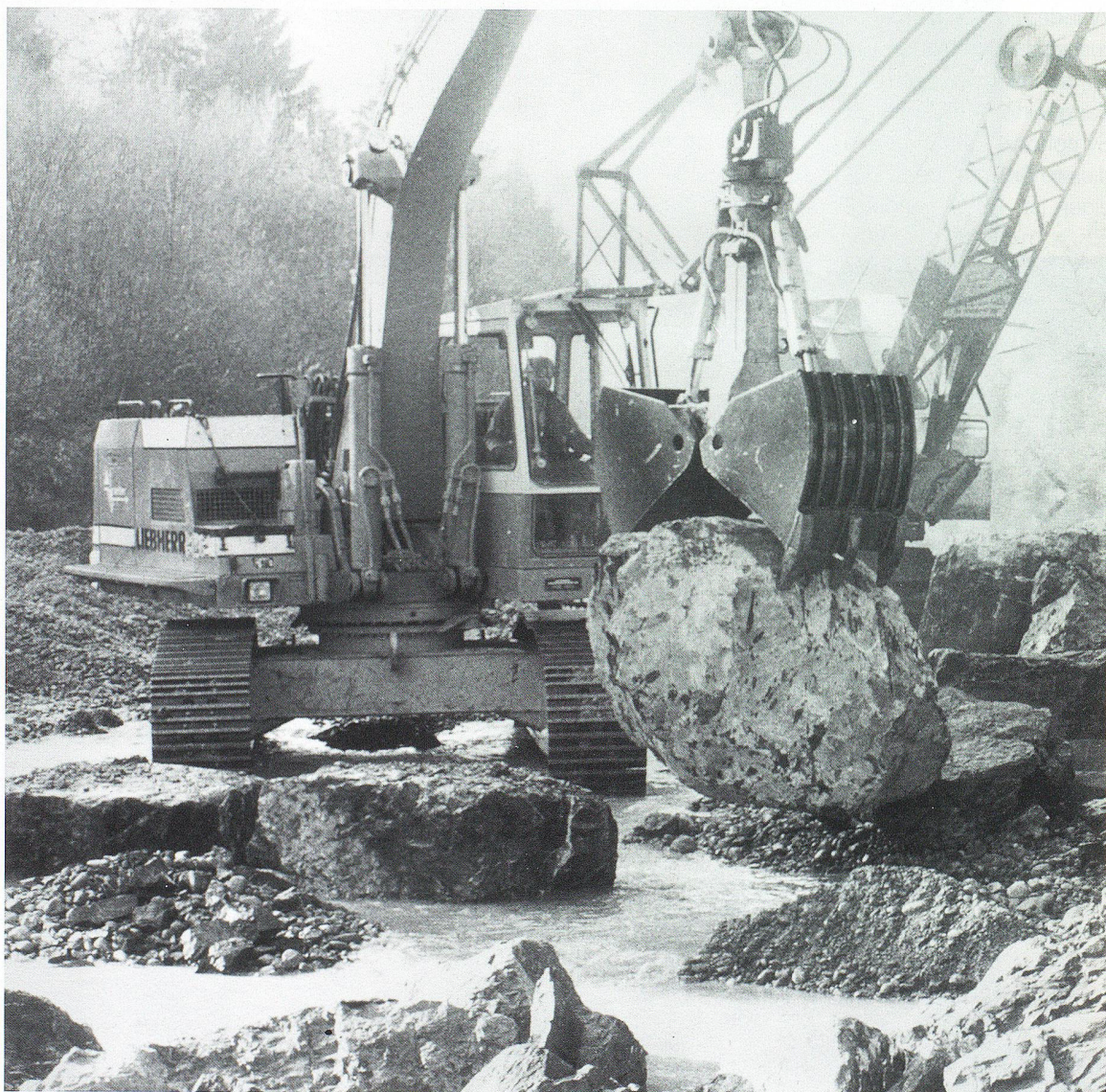
Mit modernsten Mitteln muss der wilde Lauf der Thur immer wieder gebändigt werden.
