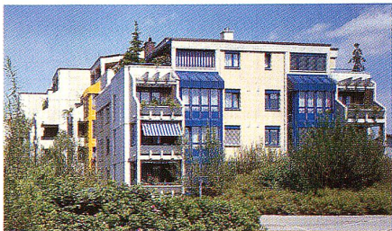
Erkerverglasungen an der Bergholzstrasse in Wil
