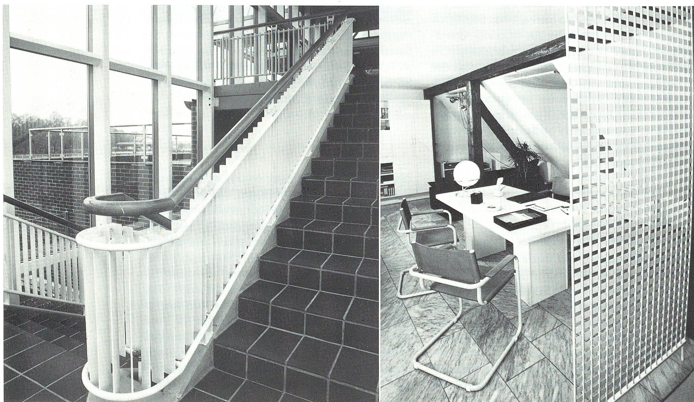
Heizkörper einmal anders: links als Treppengeländer, rechts als Trennwand
