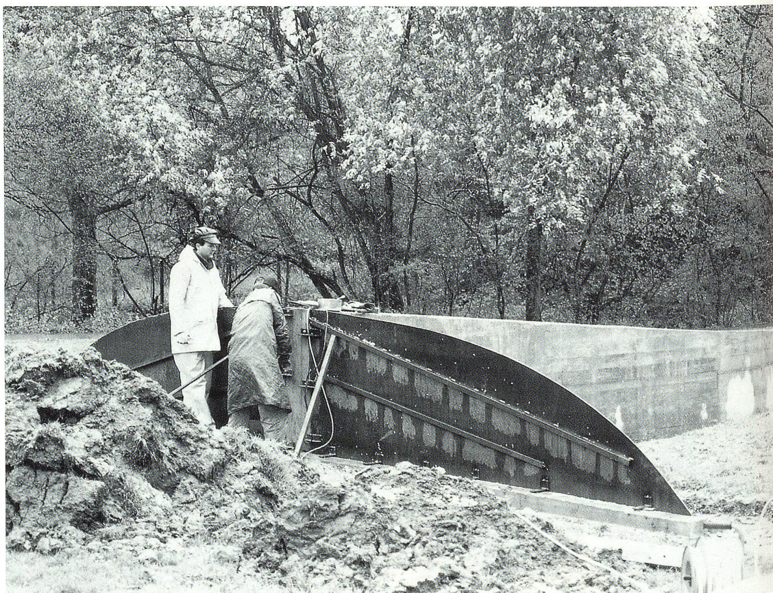
Die Wiler Plastiker Beni Salzmann und Max Zeintl vertreten die Äbtstadt an der «Eisen 89» in Dübendorf
