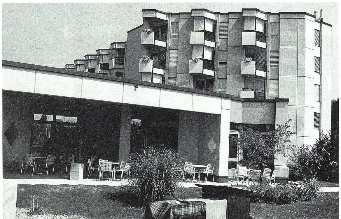
Aussenansicht des Wiler Altersheims.
