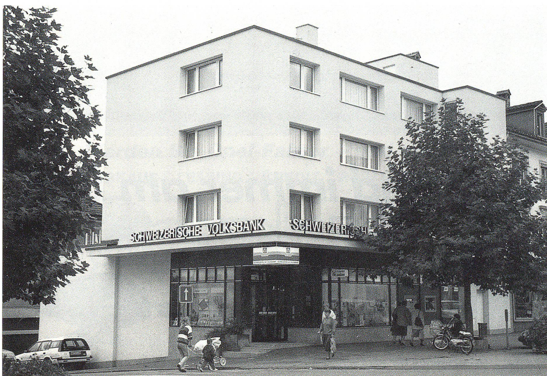
Postgebäude an der Oberen Bahnhofstrasse, davor alte Postkutsche. Auf dem Postgebäude Turmaufbau für Telefonleitungen. Später beherbergte dieses Haus die Firma Brockmann (oben). Heutiges Gebäude der Volksbank (unten).
