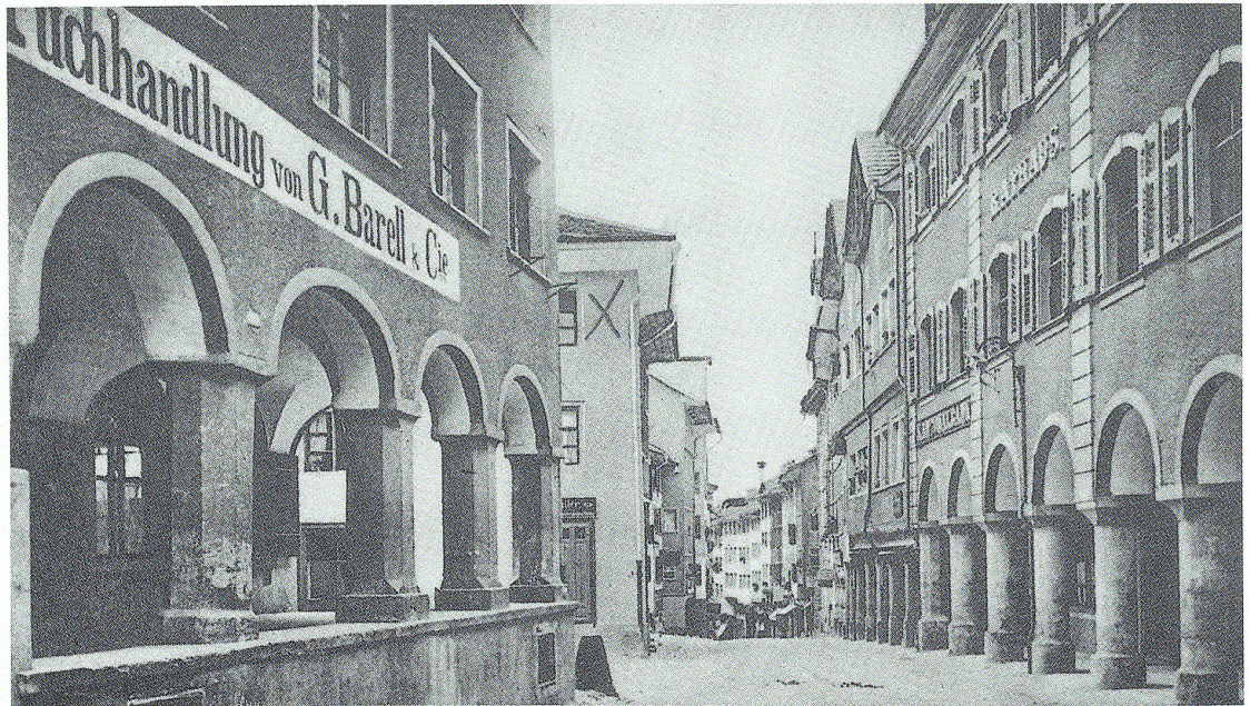
Marktgasse mit Arkaden. Links das Geschäftshaus von G. Borell & Co. (erbaut 1877, abgebrochen 1962) (oben). Heute Sparkasse der Admini- stration (unten). Wirtschaft zur Rose, ein deko- rativer und markanter Bau aus dem Jahr 1898, abgebrochen 1970 (nächste Seite links). Neubau mit dem Mr. Pick- wick-Pub und Büroräumlich- keiten (rechts davon).
