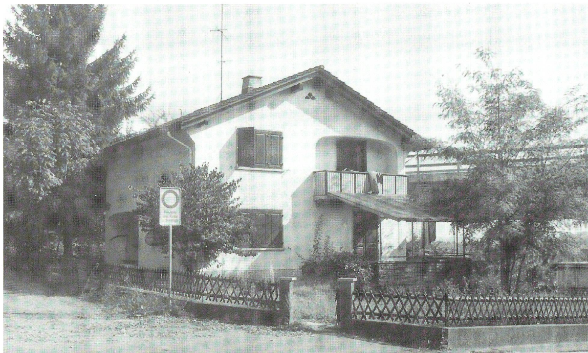
Die Kapazität der Notschlafstelle der Gassenarbeit an der Flawilerstrasse hat die Grenze erreicht. Ein weiterer Ausbau drängt sich auf.
