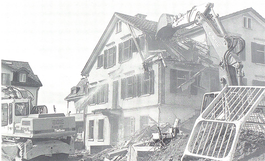
Abbrucharbeiten der beiden alten Häuser an der Bronschhoferstrasse
