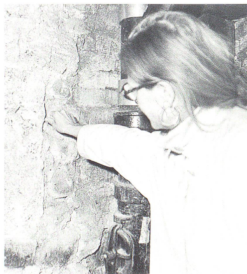
Die Architektin und Projektleiterin Margareta Peters untersucht die Beschaffenheit einer Kellermauer.
