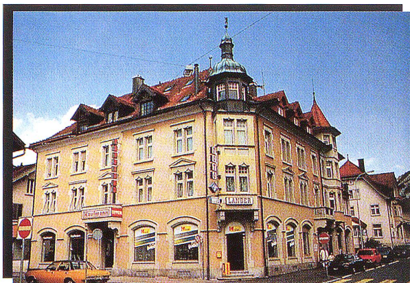
Orientteppiche im Ostflügel, Spannteppiche und Bodenbeläge im Showroom Westflügel im Geschäftshaus am Bleicheplatz.
