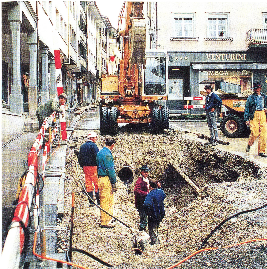
Mehr als sieben Monate dauerten die Sanierungsarbeiten der Werkleitungen in der Wiler Altstadt
