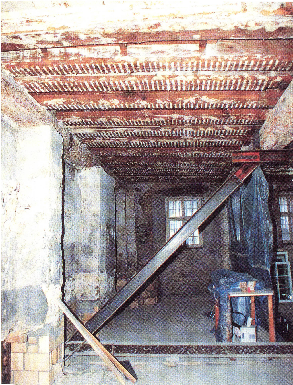
Die wertvolle Holzdecke aus dem 16. Jahrhundert wird beibehalten, ebenfalls die beiden erhaltenen ursprünglichen Sandsteinsäulen.
