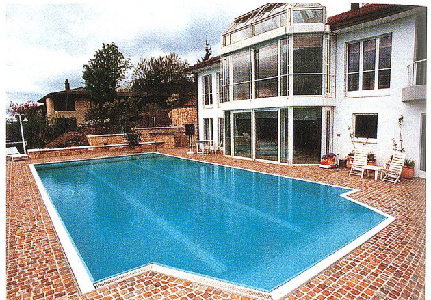
Pool mit Überfluterrinne, 8 x 14 m, Rolladenkasten am Beckenboden Bassin avec goulotte, 8 x 14 m, caisson de recouvrement à rouleau sur la plage du bassin
