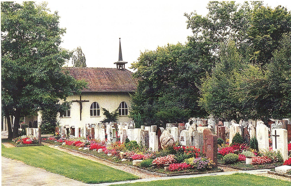
Ebenfalls saniert werden die Friedhofskapelle und das Aufbahrungsgebäude.
