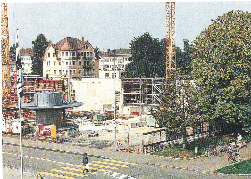
Die Bauarbeiten werden bis Herbst 1999 dauern.
