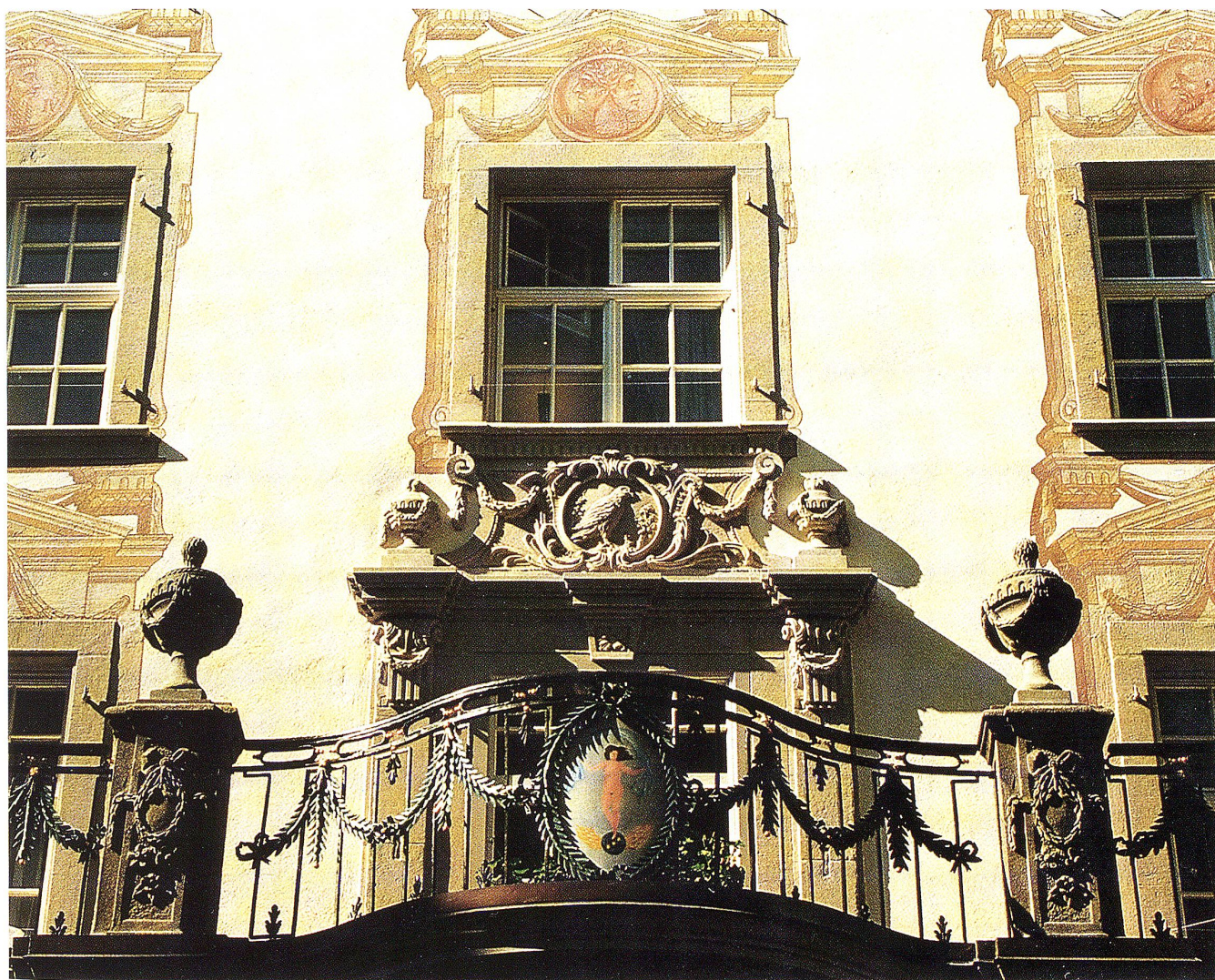
Teilansicht: Balkon und Fensterfront Baronenhaus
