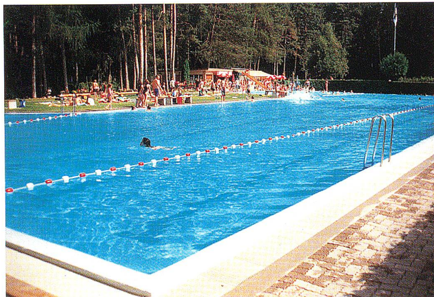
Schwimmbad Thusis (GR), Sanierung und Abdichtung mit DELIFOL-Auskleidung, 1991 Piscine de Thusis (GR): assainissement et étanchement par revêtement DELIFOL, 1991
