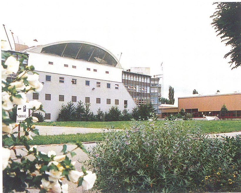
Thomann AG: Der Neubau ist eines der architektonisch markantesten Bauwerke Münchwilens.
