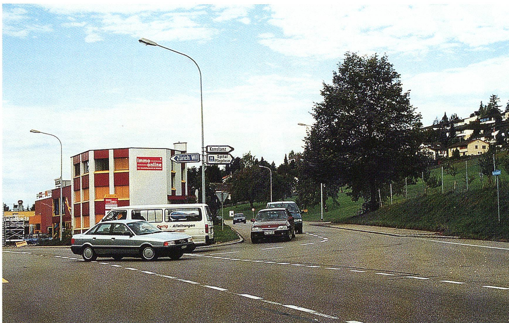
Das Parlament lehnte das Korrektionsprojekt für die Einmündung der Fürstenland- in die St. Gallerstrasse ab – damit bleibt die Spitzkurve weiterhin ein Ärgernis.
