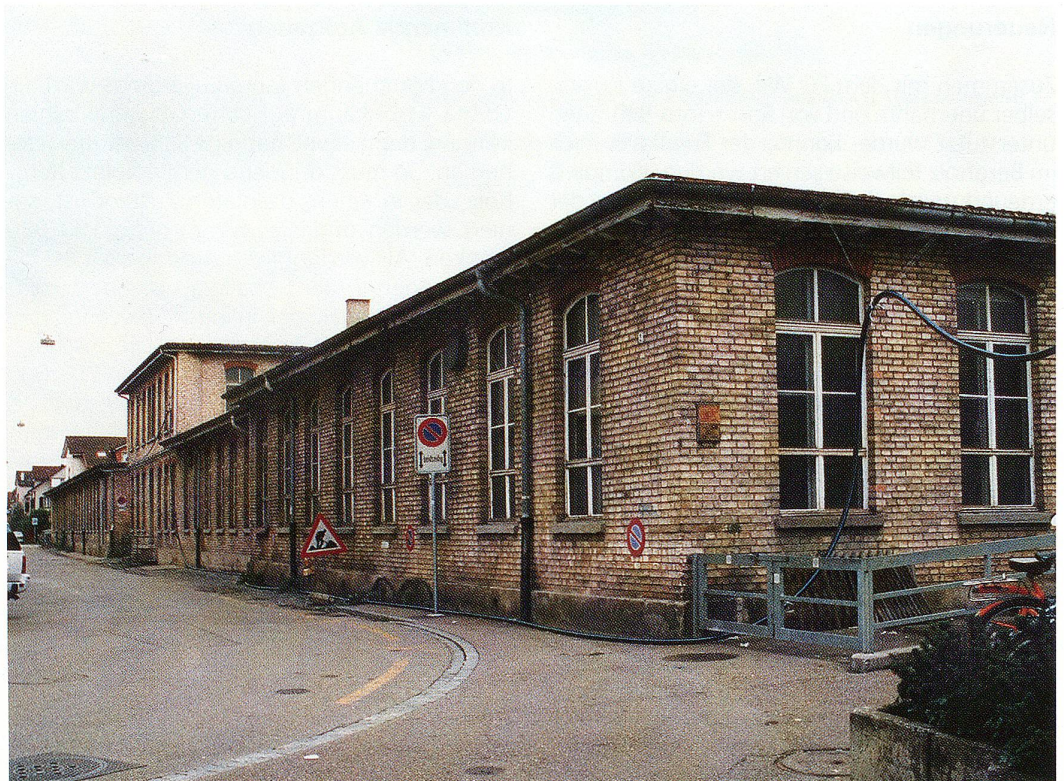
Das 1896 als Stickerei erbaute Fabrikgebäude wird im Sommer abgebrochen.
