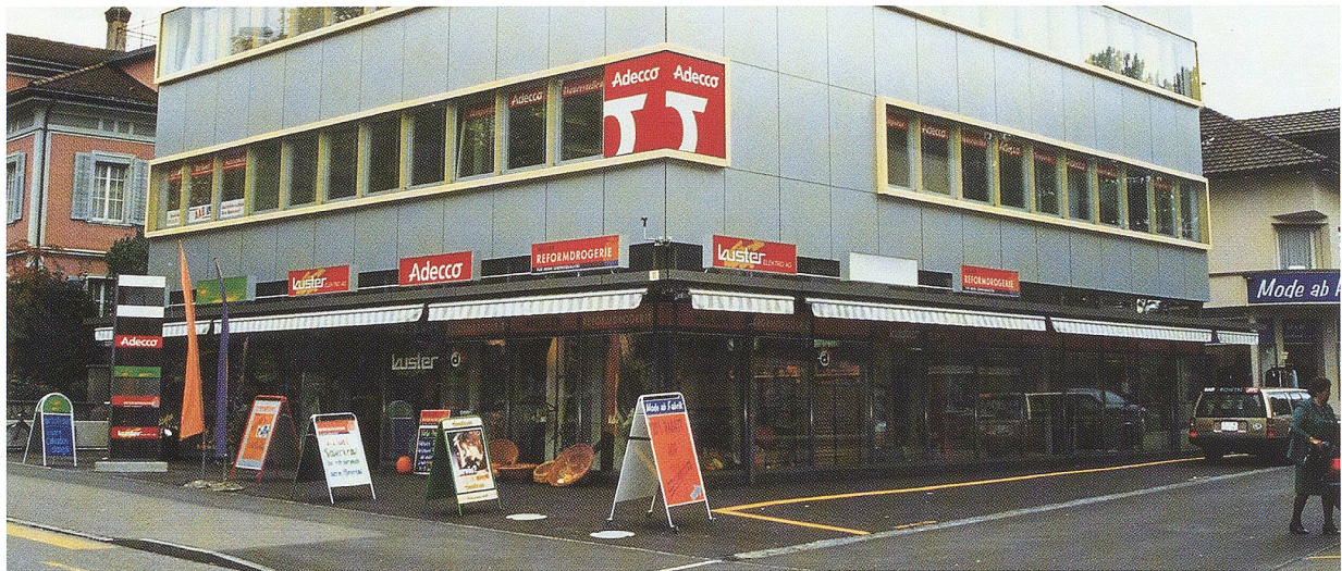
Das neue Geschäftshaus Kuster an der Oberen Bahnhofstrasse 11 in Wil wurde Ende 1998 bezogen.
