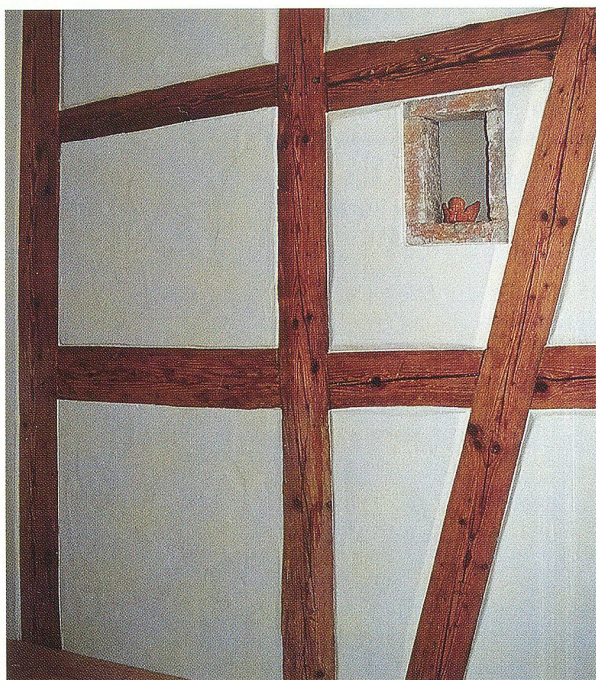
Sichtbarer Riegel
