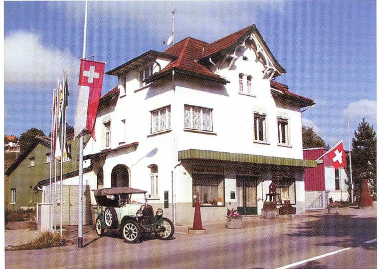
Ehemaliges Wohnhaus mit Schmiede, erbaut 1906
