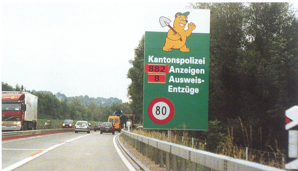
Die Kantonspolizei kontrolliert rigoros den Verkehr auf der Baustelle A1 und büsst Verkehrssünder in grossem Ausmass.
