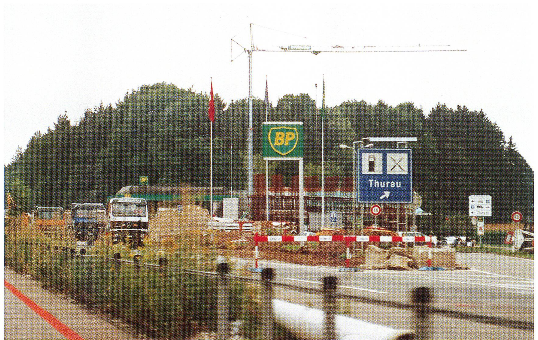
Die Raststätte Thurau Nord ist auf Grund der Bautätigkeiten vom Lebensnerv abgeschnitten.
