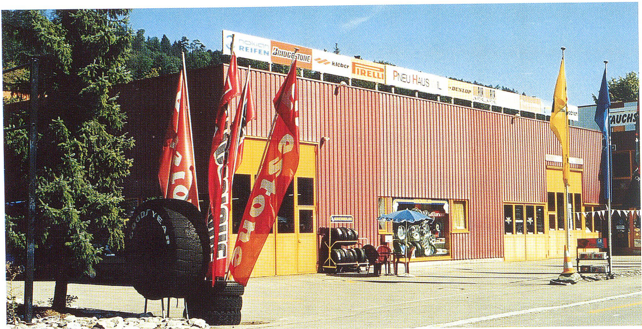
Das Pneu Haus Wil an der St.Gallerstrasse 82 wird im kommenden Frühjahr 20 Jahre alt.
