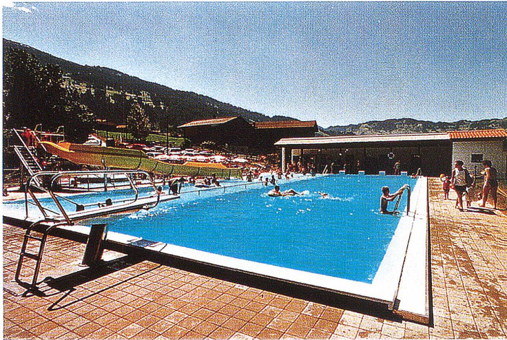
Ansicht Schwimmerbecken mit Sprungbrett und Rutschbahn
