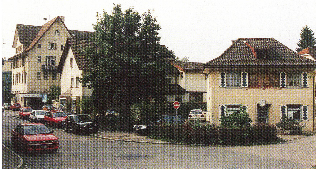
Die Bauinvestitionen betragen im Zentrum Süd (ohne Land, inkl. Mieterausbau) rund 50 Millionen Franken.
