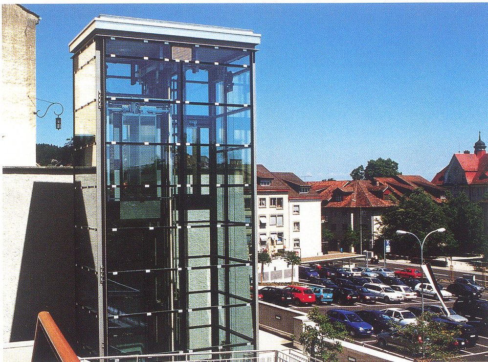
Wenn Parkplätze aufgehoben werden, muss die Infrastruktur der Umgebung stimmen: Mit dem Lift gelangt man bequem vom Parkhaus Altstadt auf die Kirchenterrasse in der Altstadt.
