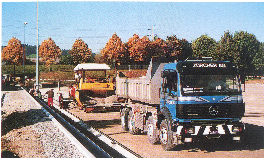
Im Oktober 2001 wird der neue Belag auf dem Allwetterplatz Bergholz sukzessive aufgebaut. Hier wird Split maschinell eingebaut.
