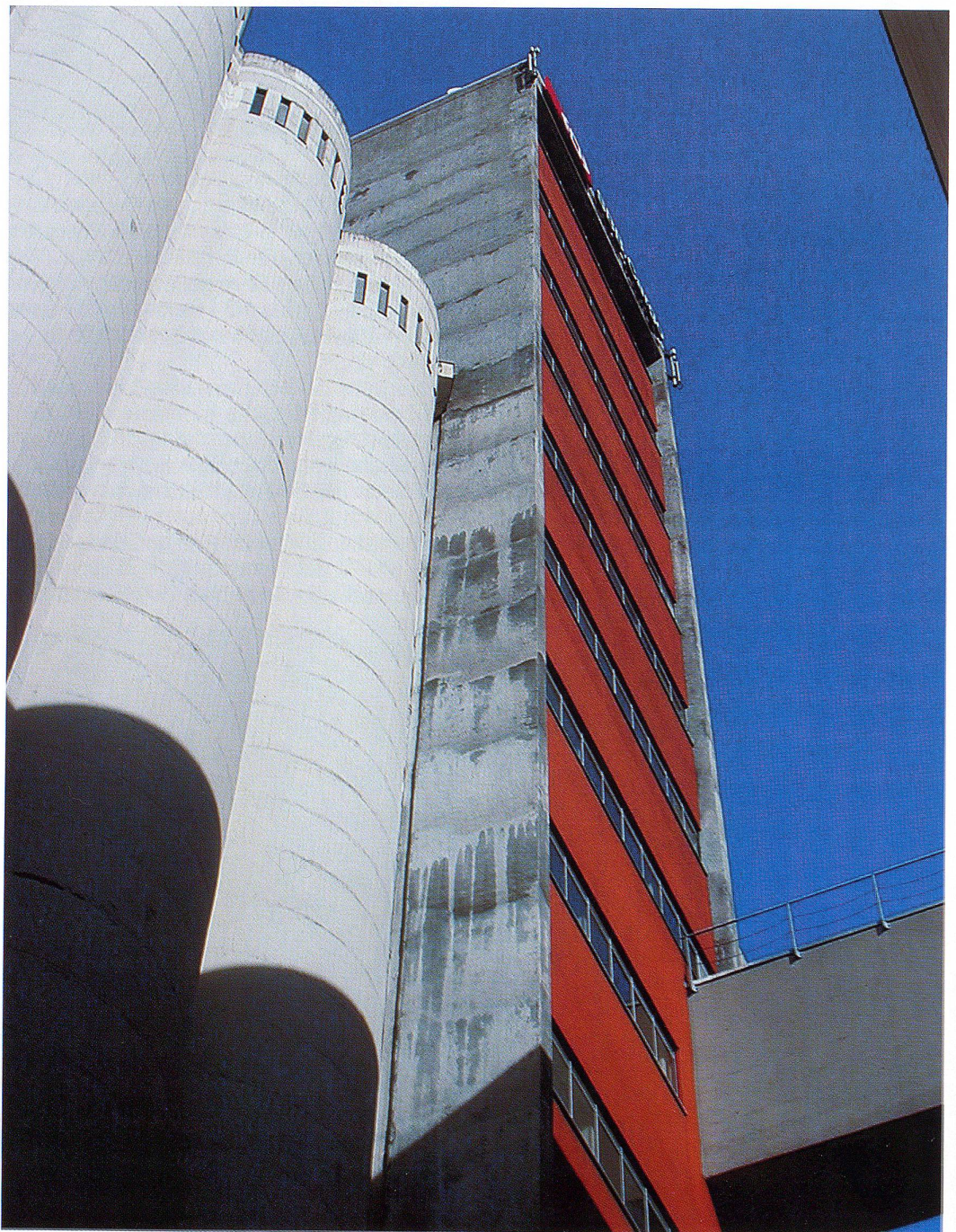
Der Wiler Getreidesilo – erbaut 1957 und weitherum sichtbar.
