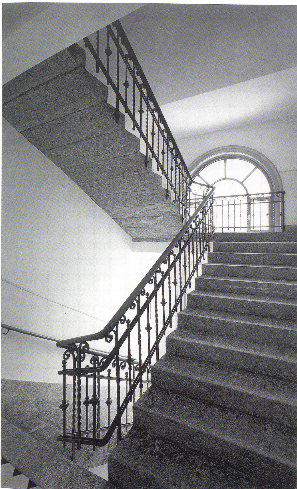
Das Jugendstil-Treppenhaus im Haus 07 wurde aufgefrischt, aber im Originalzustand belassen.
