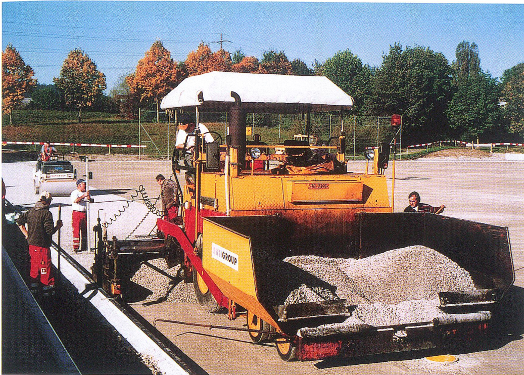
Der Split wird maschinell eingebaut
