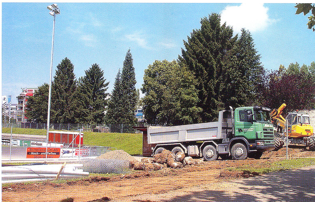
Die Baumaschinen fahren auf
