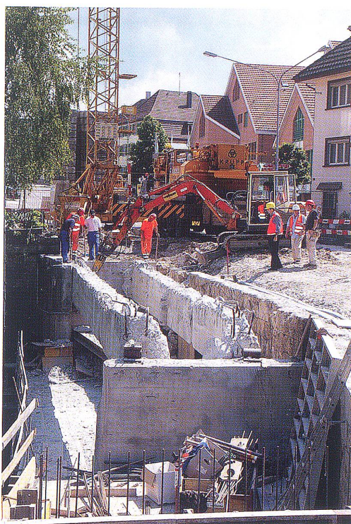
Die Alpbachbrücke in Rickenbach wird saniert.
