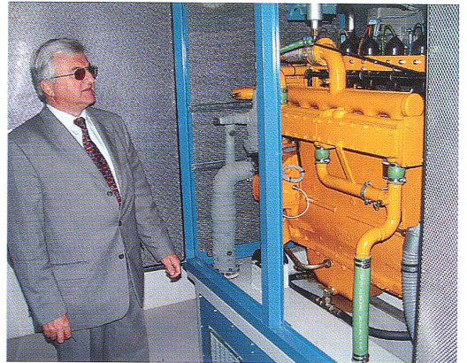
Stadtrat Werner Oertle erklärt den umgebauten Gas-Motor, der – von eigenem Biogas gespeisen – den Generator zur Stromerzeugung antreibt.
