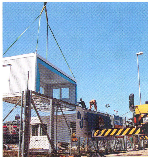
Montage der Büro-Container
