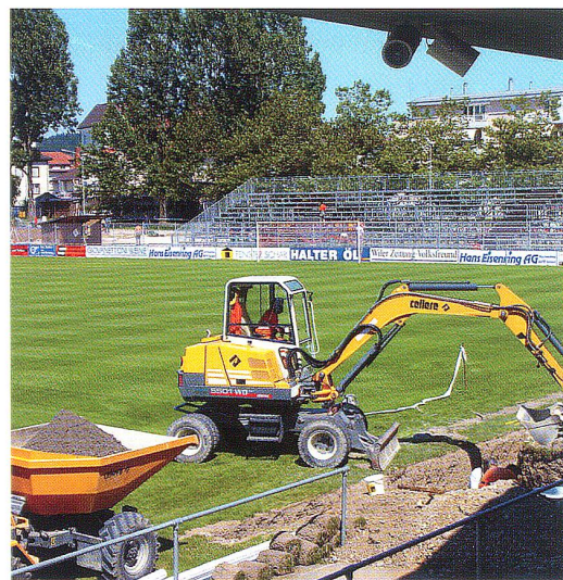
Baumaschinen auf dem Bergholz
