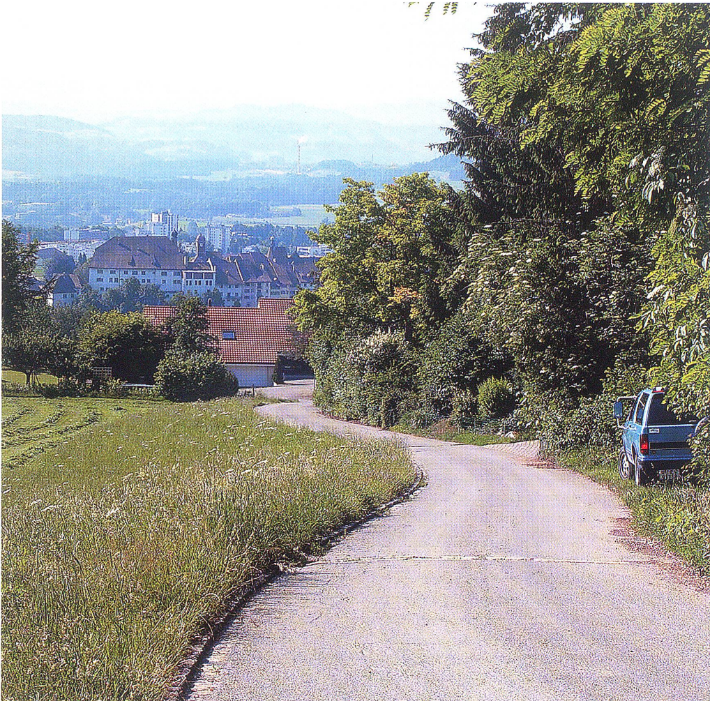
Die Obere Hofbergstrasse wird ausgebaut und die Kanalisation erneuert.
