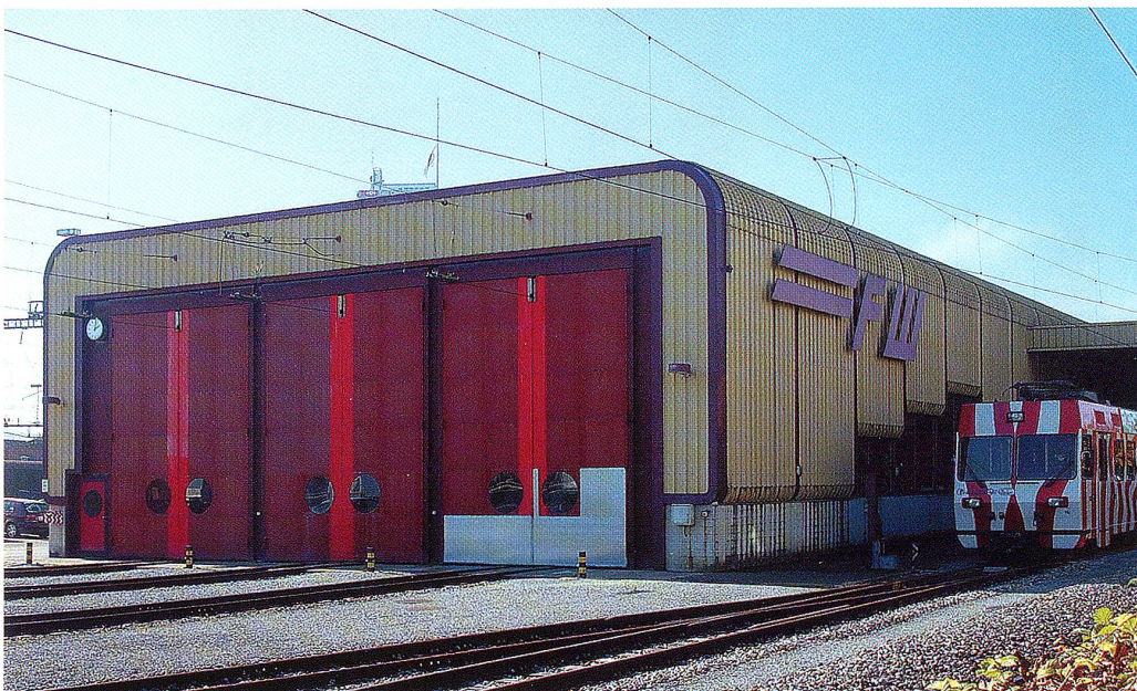
Das Betriebsgebäude der Frauenfeld-Wil-Bahn in Wil.
