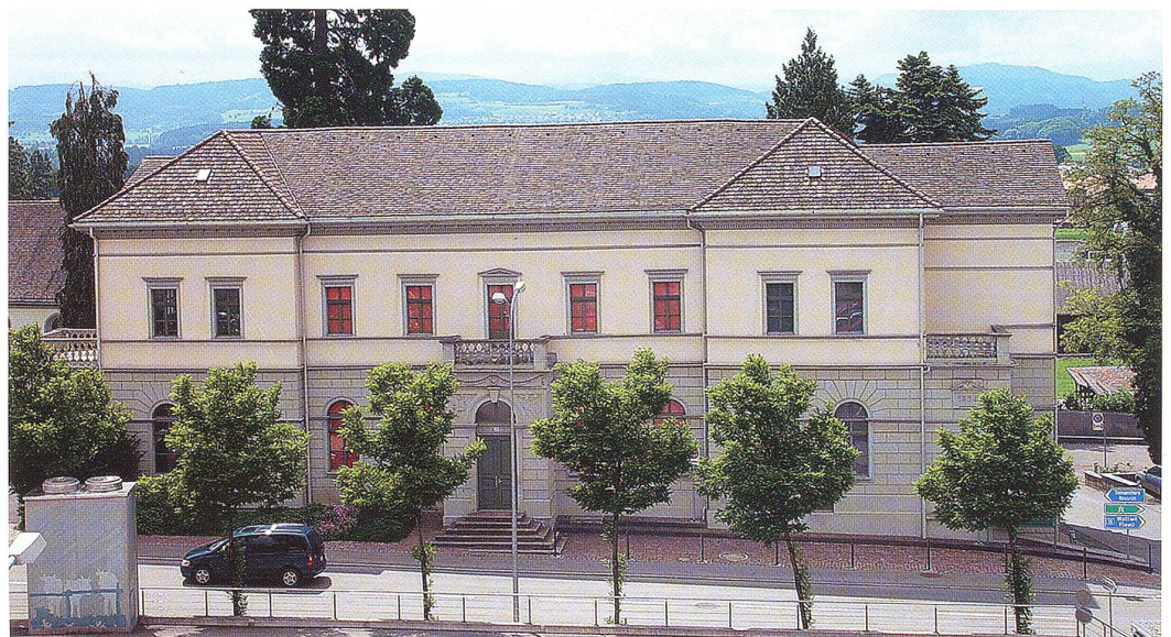
Die Tonhalle muss auch aussen saniert und Schäden an der Fassade behoben werden. Die Umgebung wird angepasst und die Aussenbeleuchtung verbessert.
