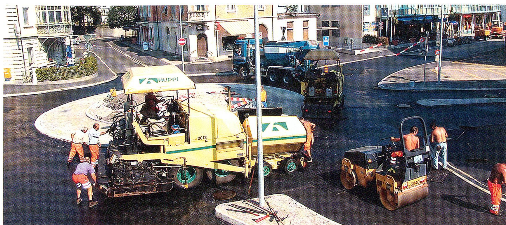
Der Belagseinbau dauerte eineinhalb Tage: Anfang August wurde der Jupiterkreisel dem Verkehr übergeben.
