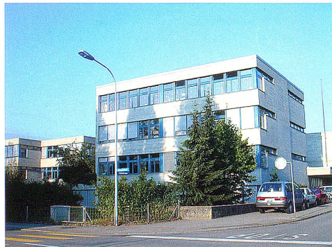
Für die Sanierung und Erweiterung des Mattschulhauses wurde ein Projektierungskredit von 790 000 Franken genehmigt.
