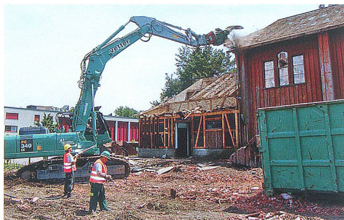
Reithalle und Wohnhaus wurden abgebrochen und mussten einem Mehrfamilienhaus weichen.
