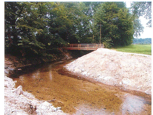
Der Alpbach wurde in ein neues Bett umgeleitet, und es wurde ein neuer Steg erstellt.
