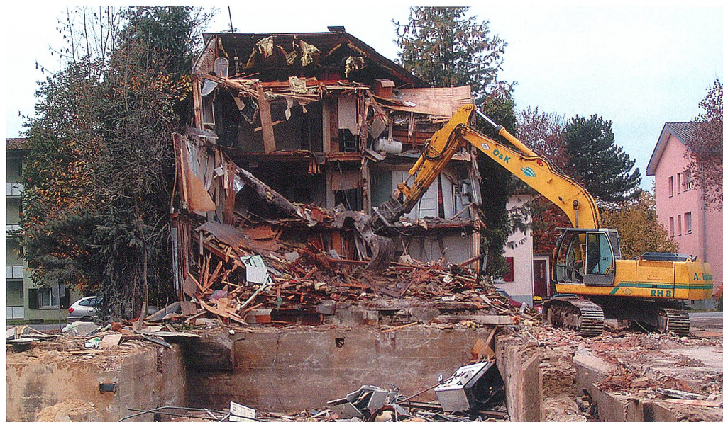
Das ehemalige Wohnhaus mit Büro wird vom Bagger abgerissen.
