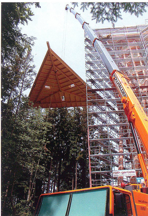
Ein Autokran hievt das 7,5 Tonnen schwere Dach auf eine Höhe von rund 36 Metern.
