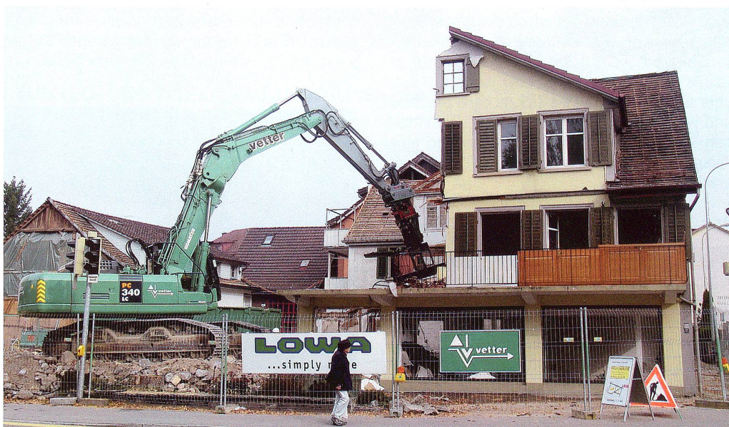
Anfang Oktober ist bei Bossart Sport am Rudenzburgplatz der Bagger aufgefahren.
