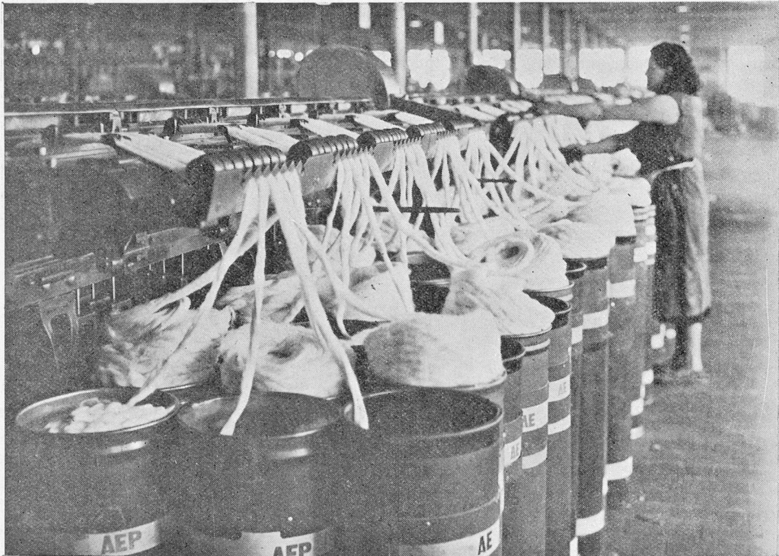
Le coton placé dans des « pots » passe sur les premiers métiers à filer
