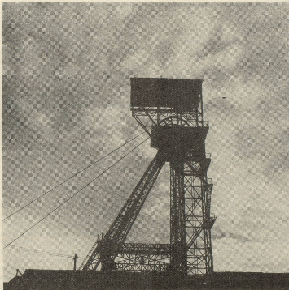
Chevalement dans le bassin de Lorraine.
