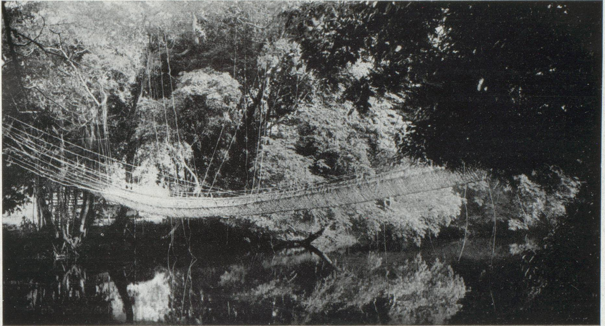
Il convient avant tout, d'améliorer les voies de communication (Pont de banes en Guinée)
