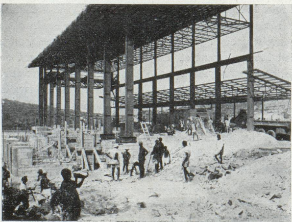
Construction de l'usine hydro-électrique de Grandes Chutes
