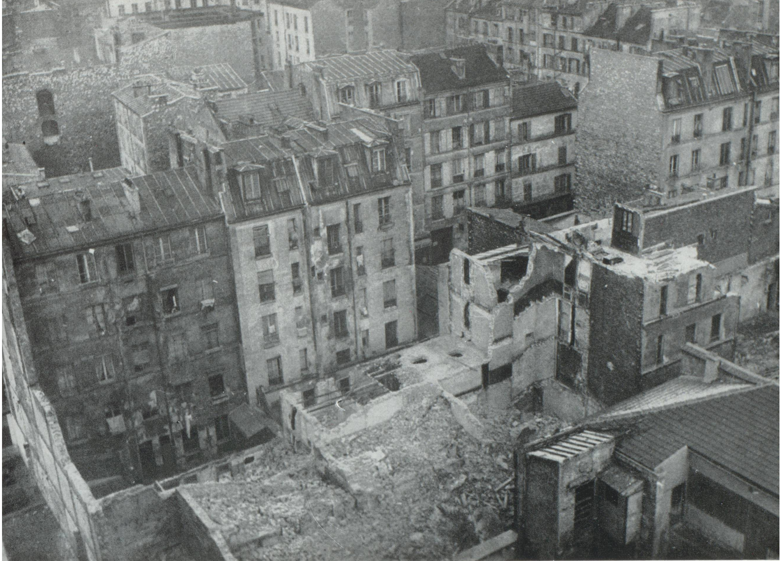
Trop de Parisiens habitent encore des taudis qu'il faut livrer à la pioche des démolisseurs. Ci-dessus, une vue de l'îlot insalubre n° 11 à Paris (photo du service technique de la Préfecture de police).
