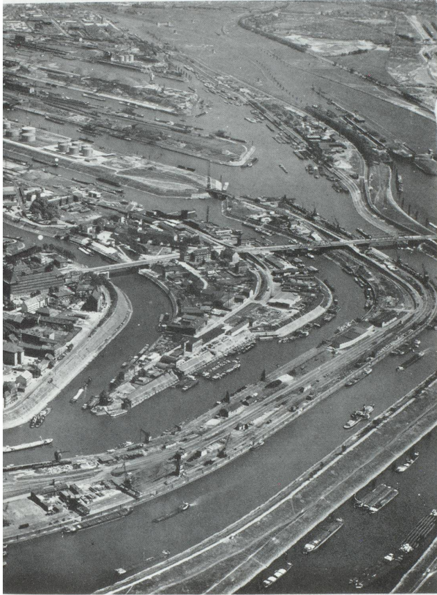
Ci-dessous : Duisbourg, premier port fluvial du monde.
