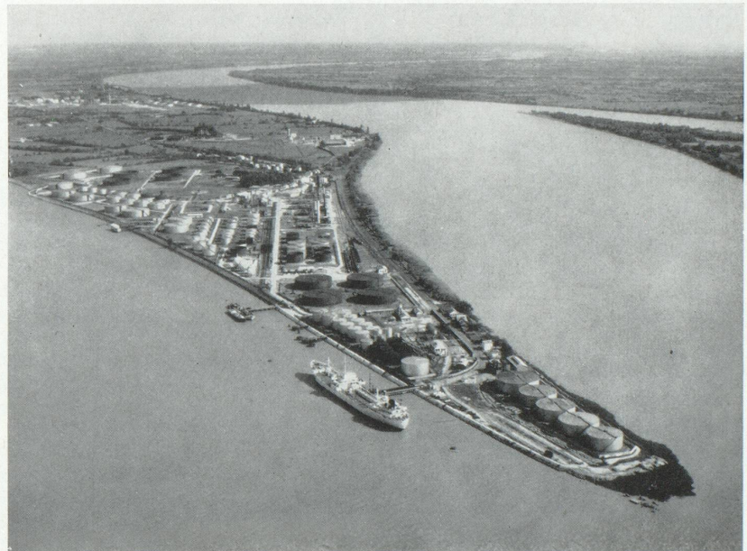
INSTALLATIONS PÉTROLIÈRES AU BEC D'AMBÈS. CONFLUENT DE LA GARONNE ET DE LA DORDOGNE
