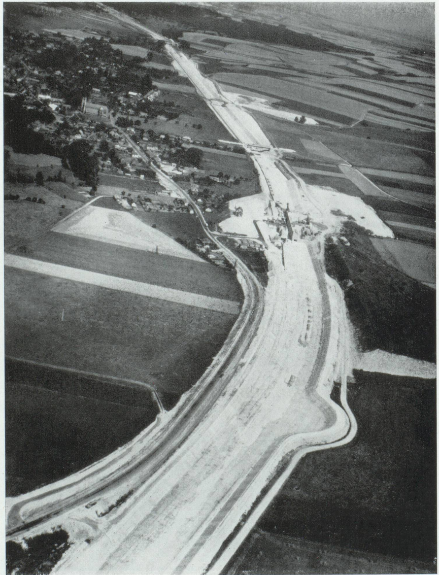
Canal du Nord en chantier.
