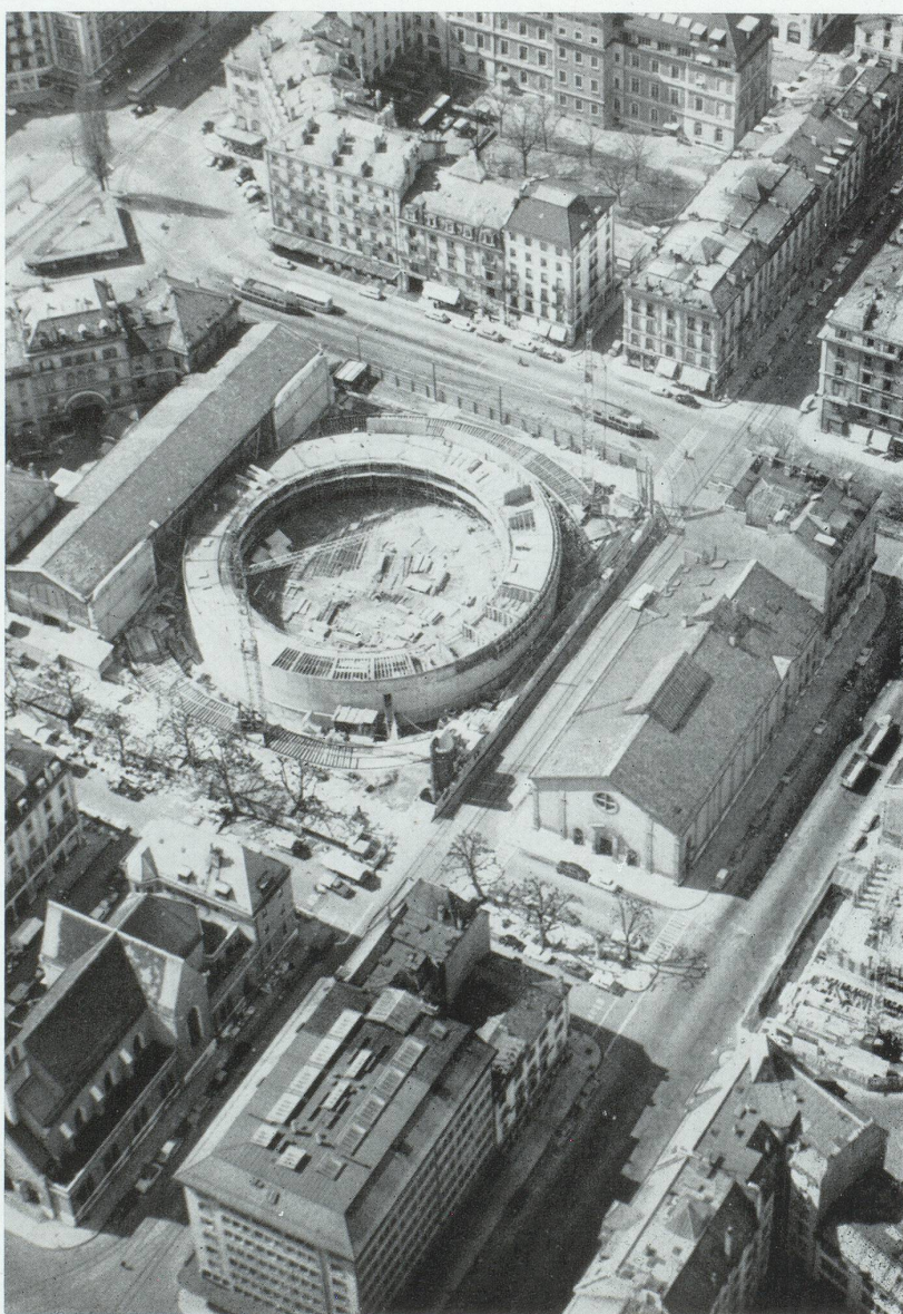
1. Le bétonnage de la première tranche du caisson. (Photo G. Klemm, Genève).
