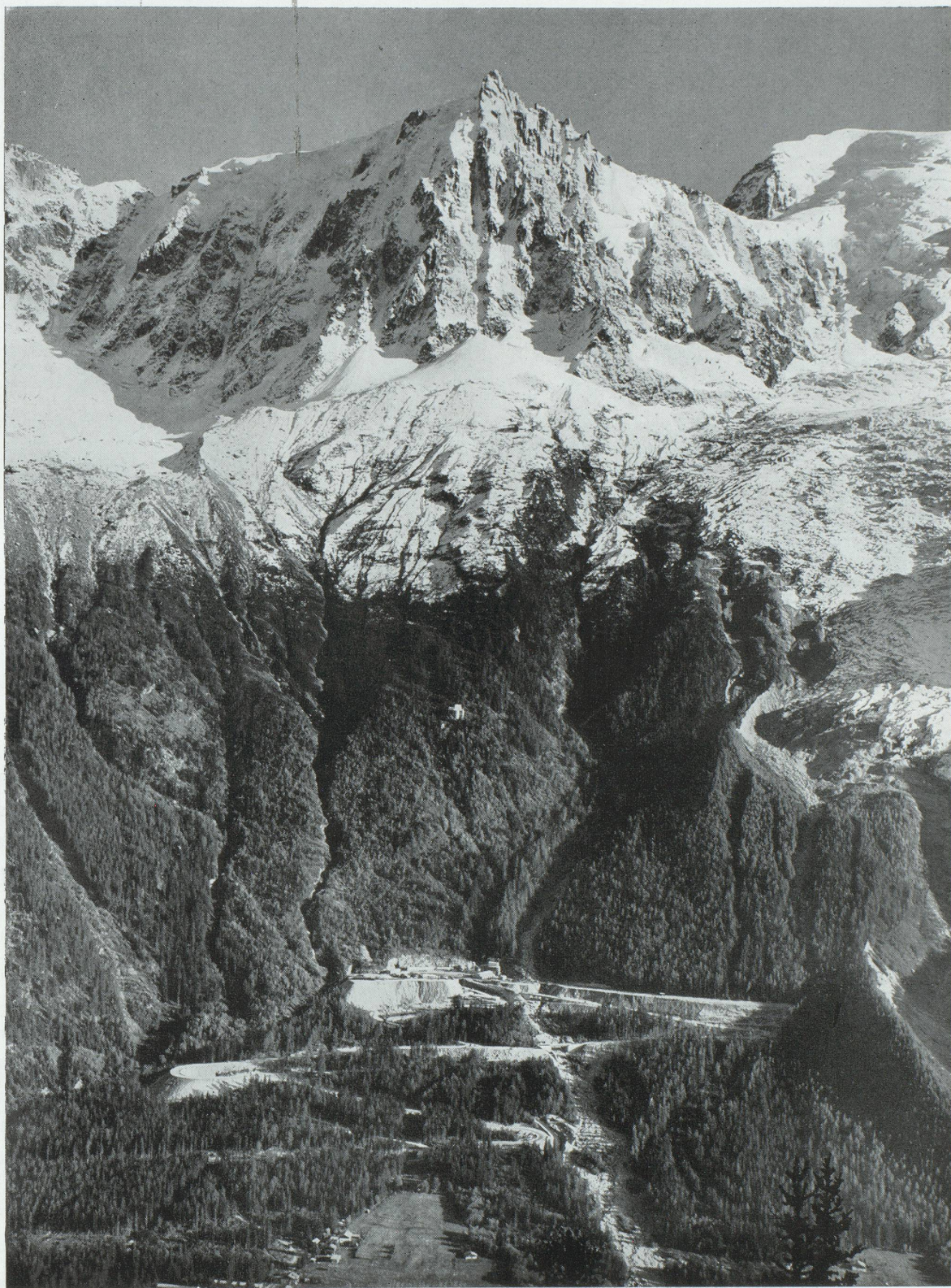
L'Aiguille du Midi (3842 m) et le chantier français du tunnel
