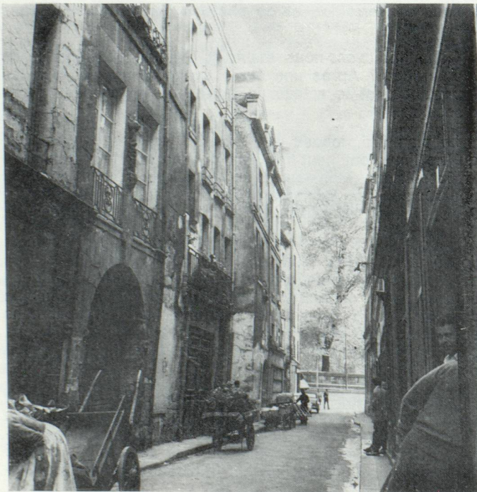
Rue de Bièvre avant restauration
