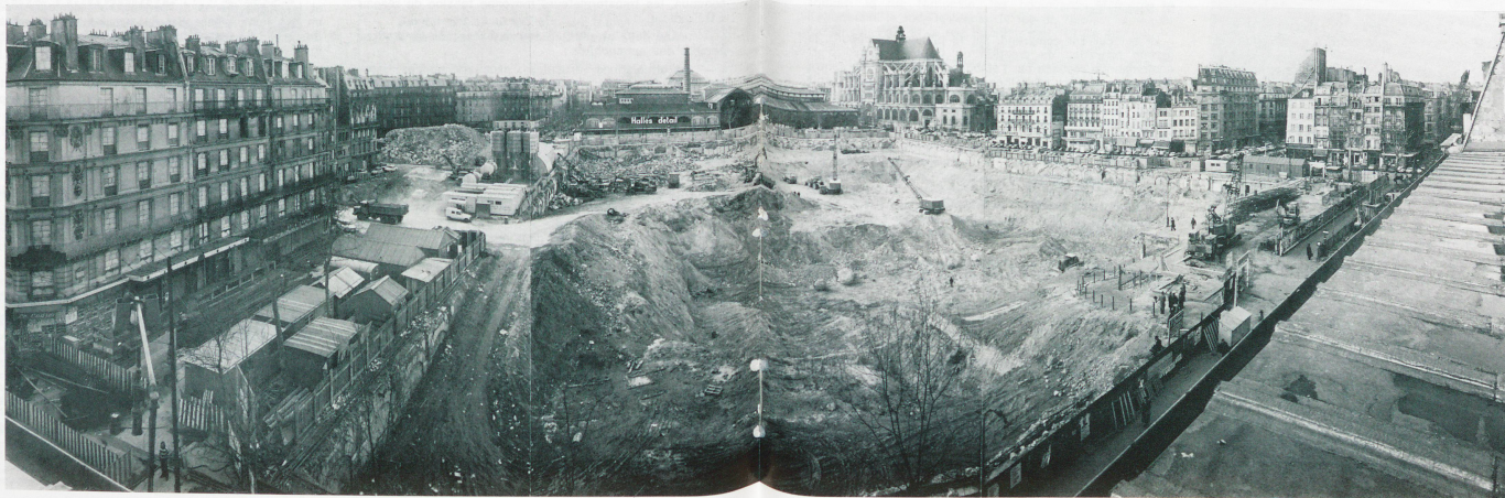
Vue panoramique du chantier des Halles (feuilles RER + Forum)
