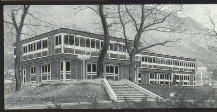
Bureaux de la Mairie de Meylan (architecte ZANASSI)
