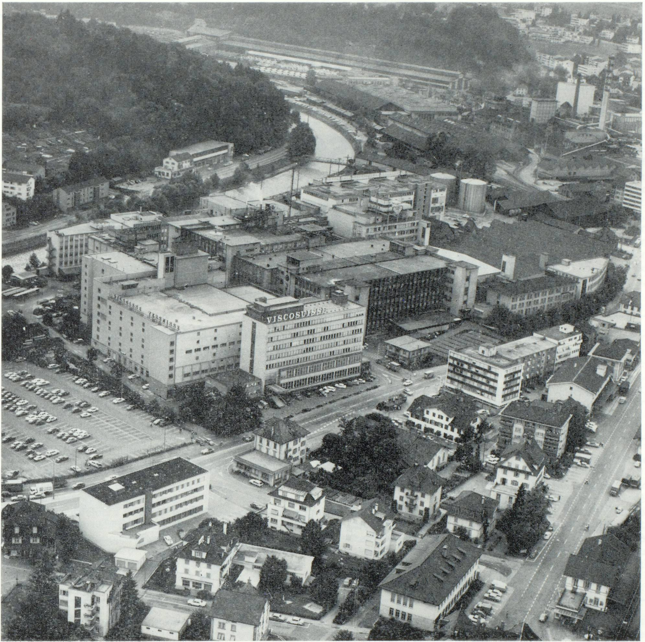
Vue générale de l'usine d'Emmenbrücke
