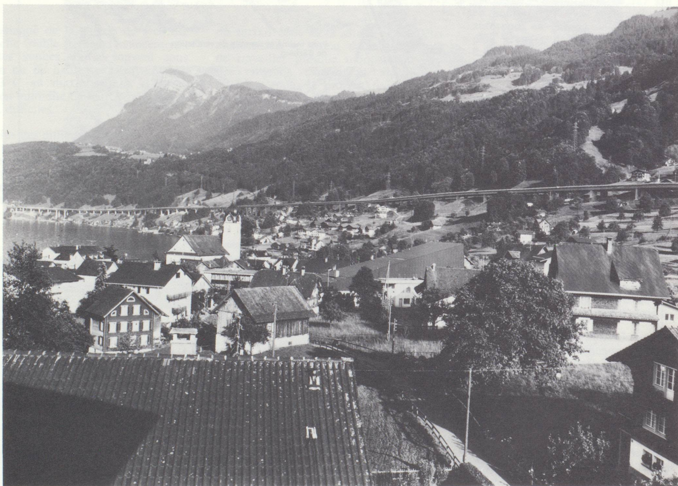
Viaduc de Beckenried ; au premier plan, le village de Beckenried
