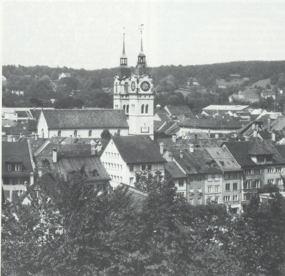
Partie médiévale de la ville de Winterthur (2 e ville du Canton de Zürich), avec l'église St-Laurent (Photo ONST).
