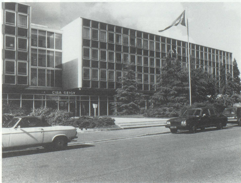
Le Siège de Ciba-Geigy France à Rueil-Malmaison.
