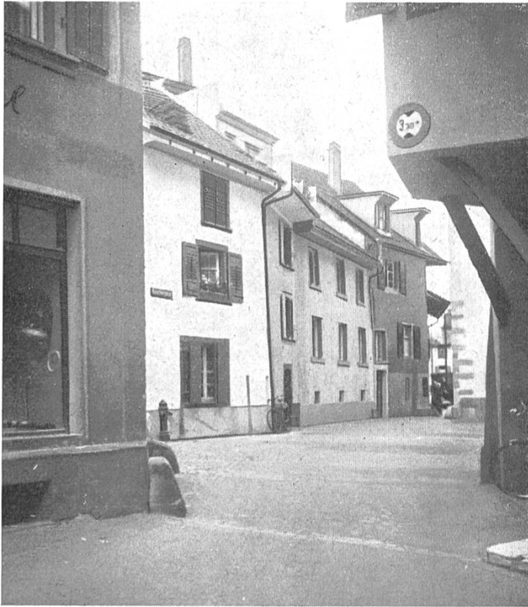
Kapuzinergasse; Obere Badstube (3 Fenster im Erdgeschoss) vom Ober- torplatz aus
