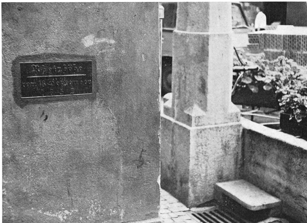
Bild 9. Hochwassermarken an der Hausecke beim Fischmarktbrunnen in der Fröschweid.
