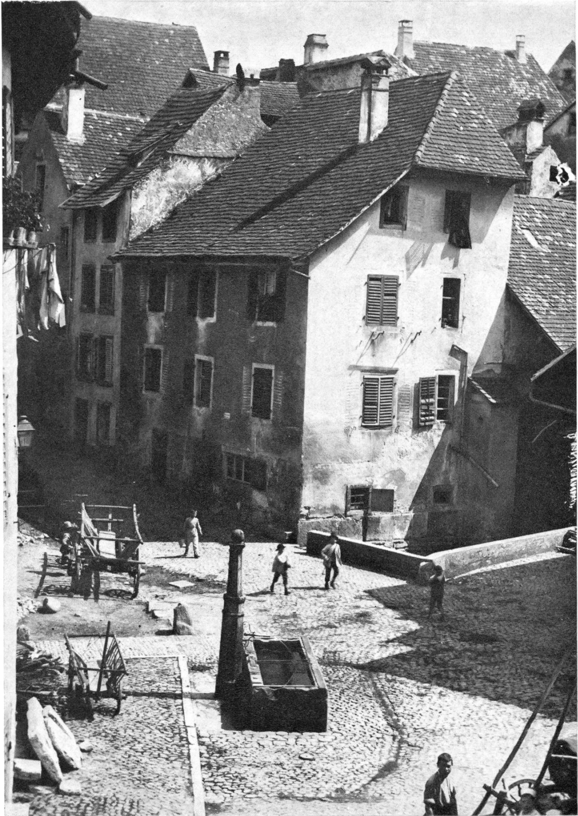
Im Rumpel. In der Bildmitte, von Mauern eingefasst, der Stadtbach.
