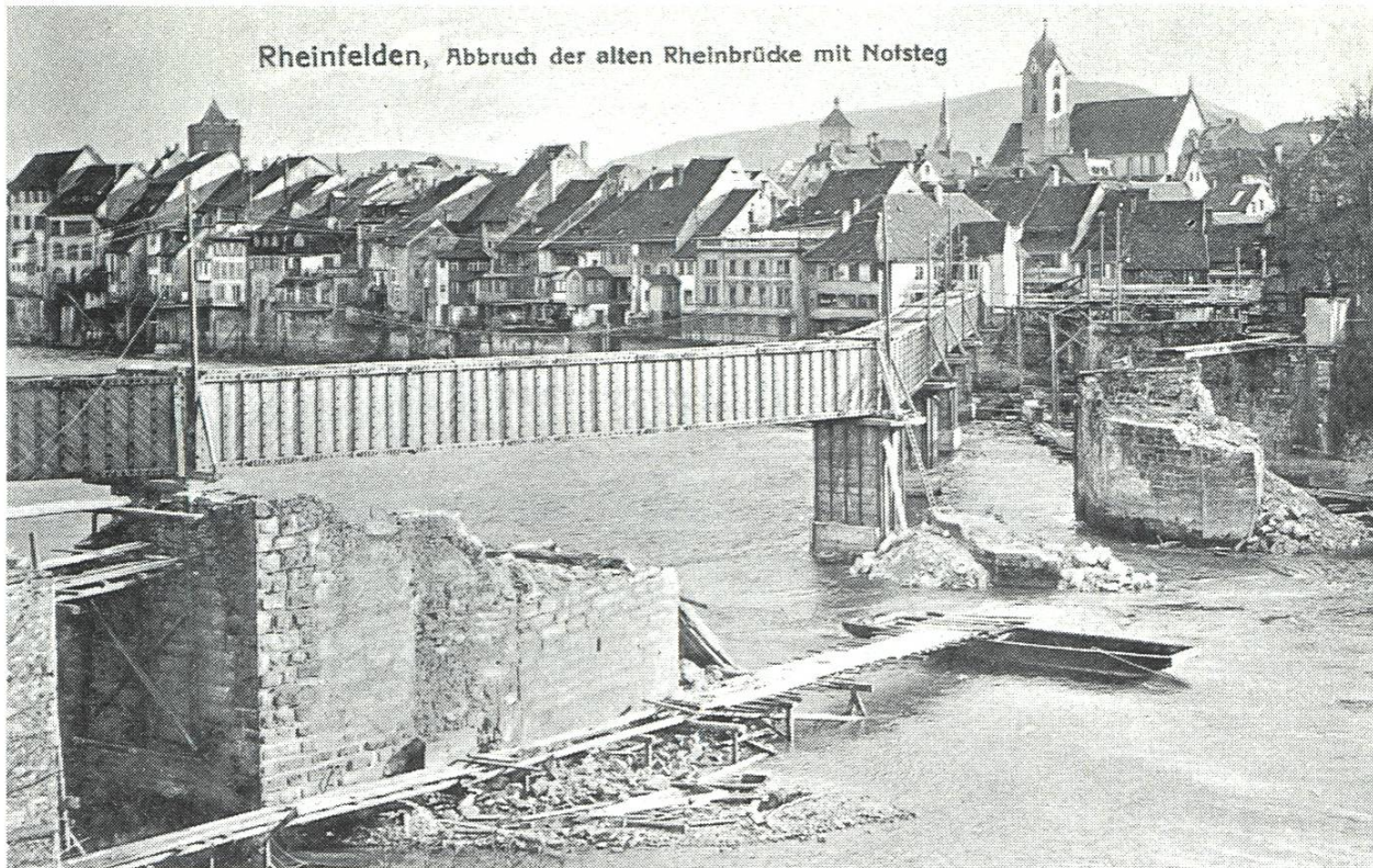
Abb. 18: Abbruch der alten Brücke mit Notsteg.
