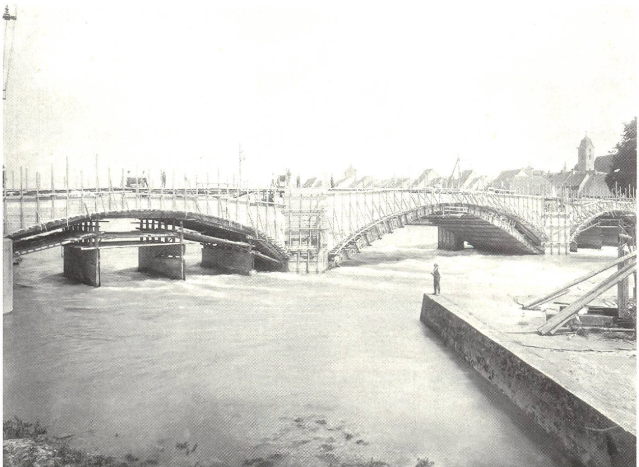
Abb. 21: Neubau der Brücke, Schalung zum Betonieren.
