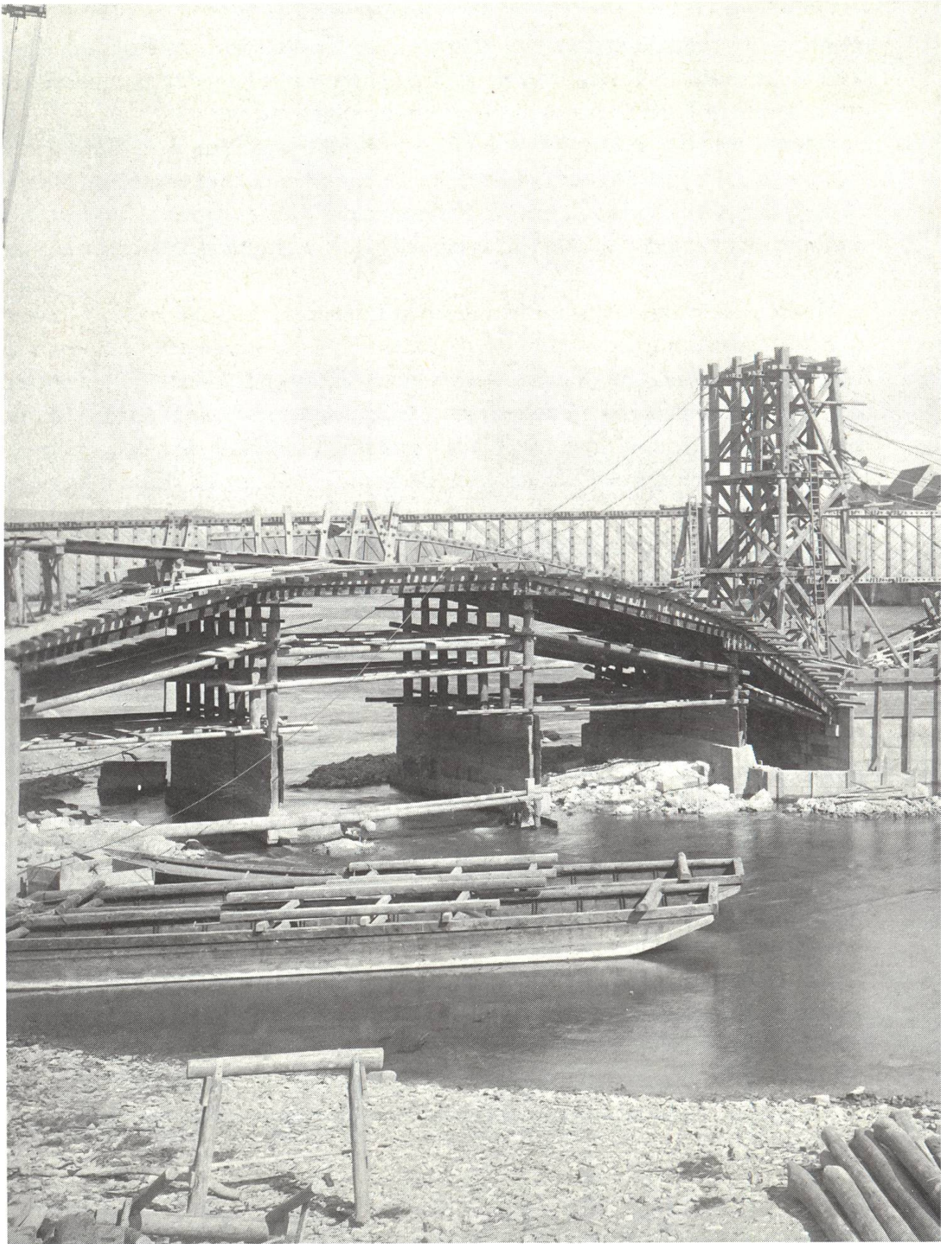
Abb. 20: Neubau der Brücke, Schalungsarbeiten.
